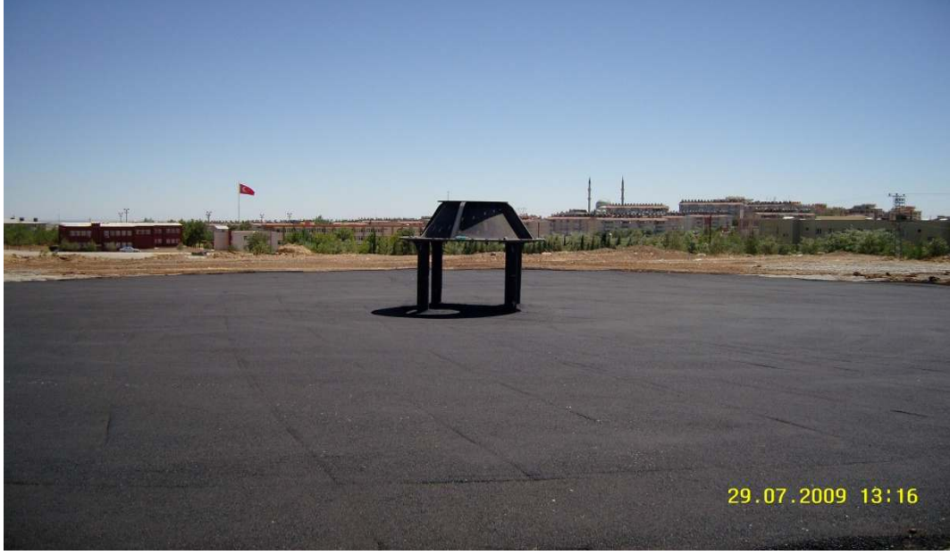
Şekil 3.15 Güneş bacası sistemin zemin yapımını gösteren fotoğraf; asfalt zemin
