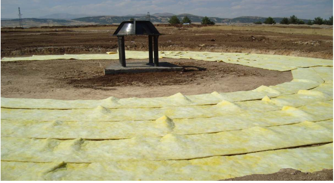
Şekil 3.11 Güneş bacası sistemin zemin yapımını gösteren fotoğraf, alüminyum folyolu cam yünü
