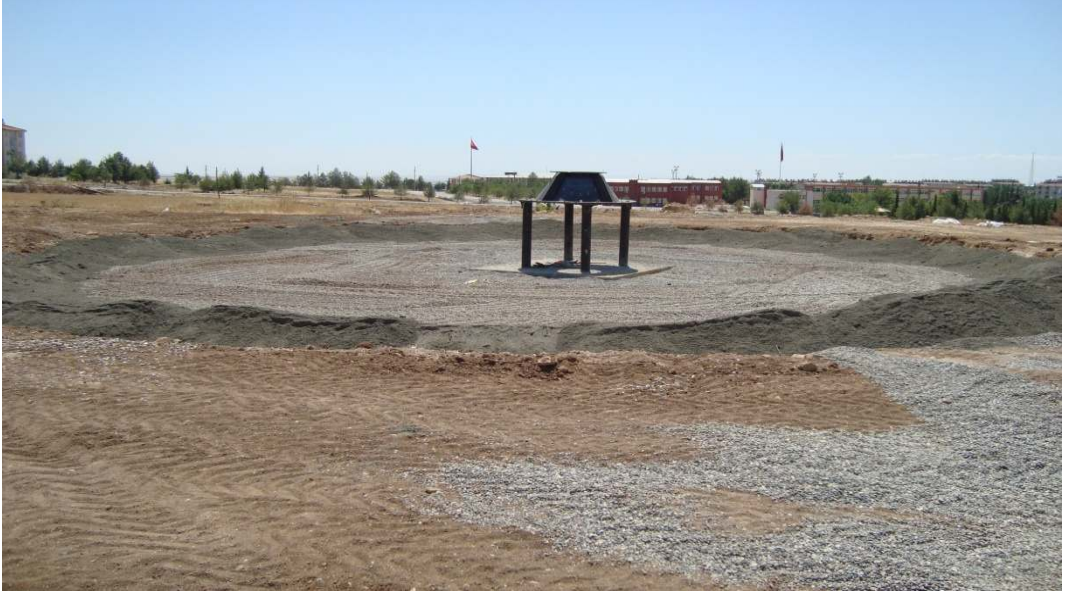
Şekil 3.13 Güneş bacası sistemin zemin yapımını gösteren fotoğraf; ince kum serilmesi
