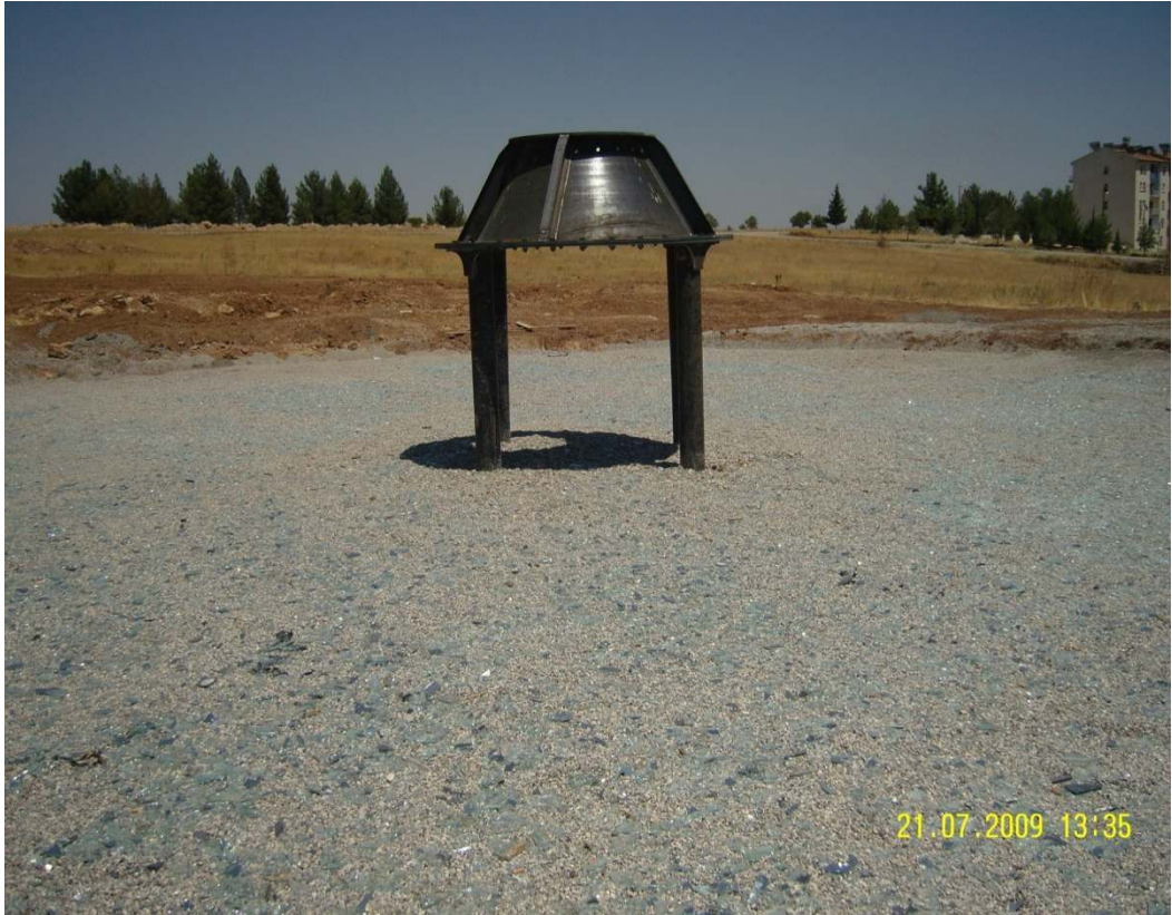
Şekil 3.14 Güneş bacası sistemin zemin yapımını gösteren fotoğraf; cam kırıklarının serilmesi
