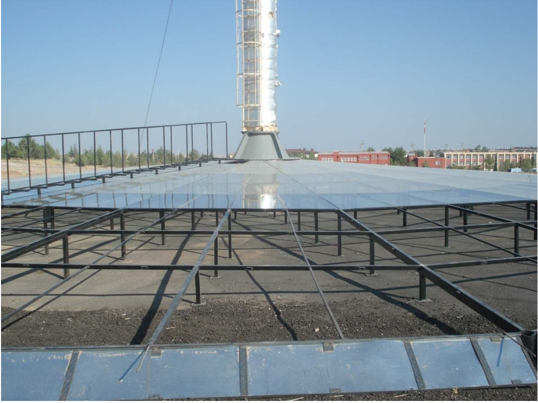
Şekil 3.21 Güneş bacası sistemi güneş kollektörünün camlarının montajı
