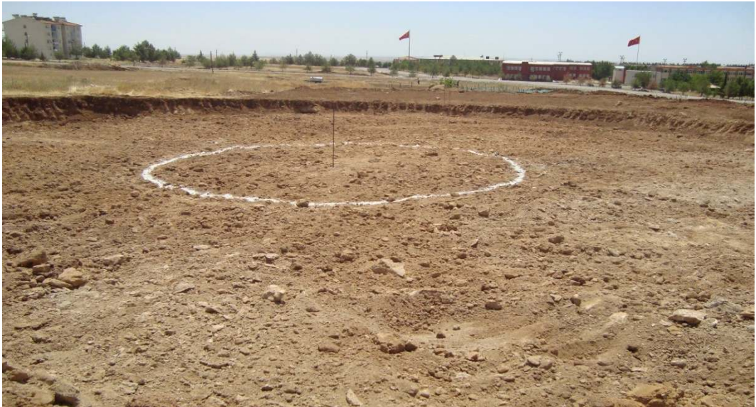
Şekil 3.10 Güneş bacası sistemin zemin yapımını gösteren fotoğraf; toprak zemin
