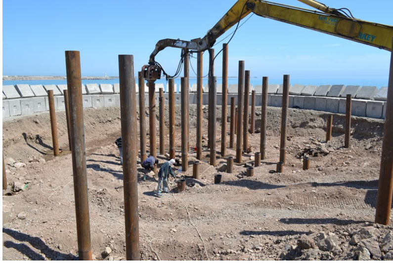
Şekil 2. Çelik kazıkların uygulamada gösterimi
