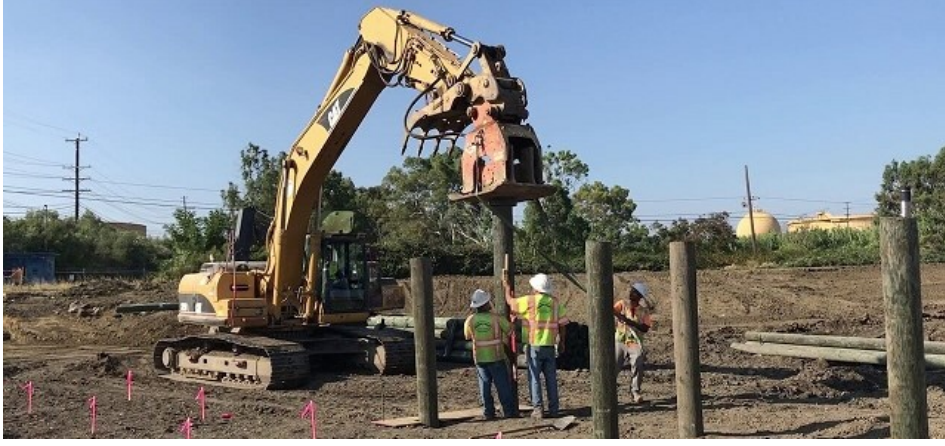
Şekil 1. Ahşap kazıkların uygulamada gösterimi
