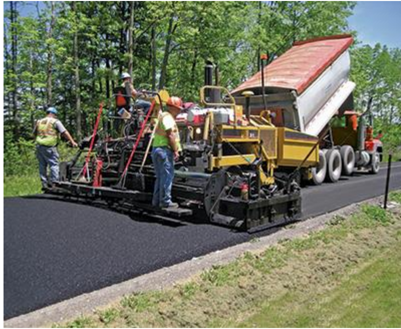
Şekil 2.12. State Route- Spring Mills, PA yakınlarında 2012'de bir IKA uygulaması
