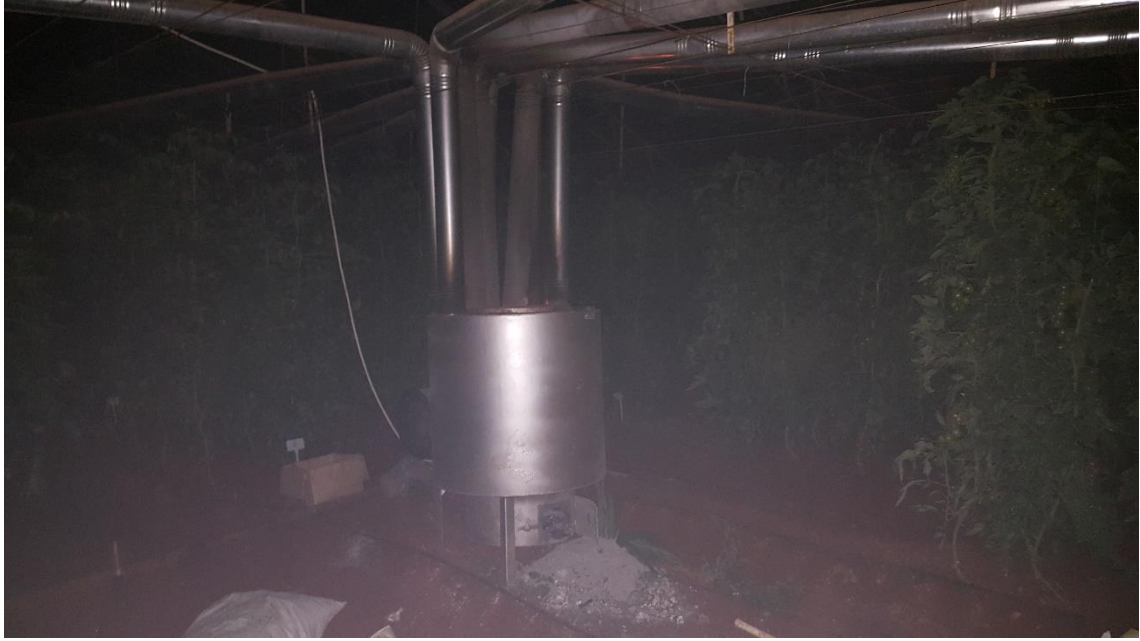
Şekil 3.10. Sera ısıtması amacıyla kullanılan kömür sobasından bir görünüm
