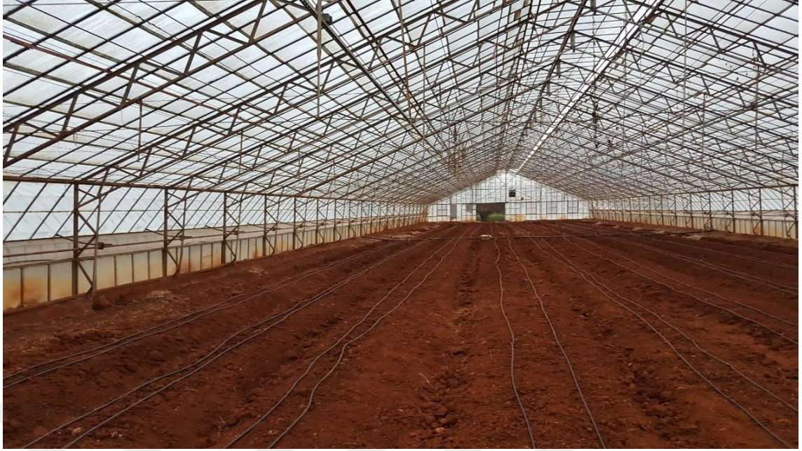
Şekil 3.4. Damlama borularının çekilmesinden bir görünüm
