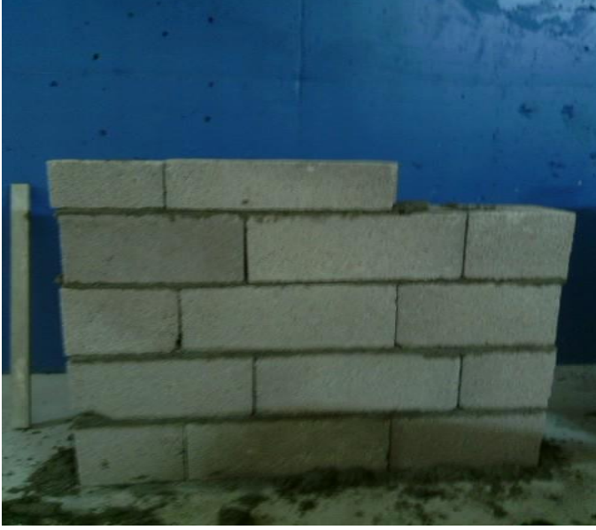
Bimsblok ile duvar örülmesi
