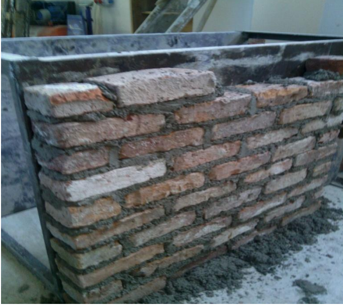
Harman tuğlası ile duvar örülmesi
