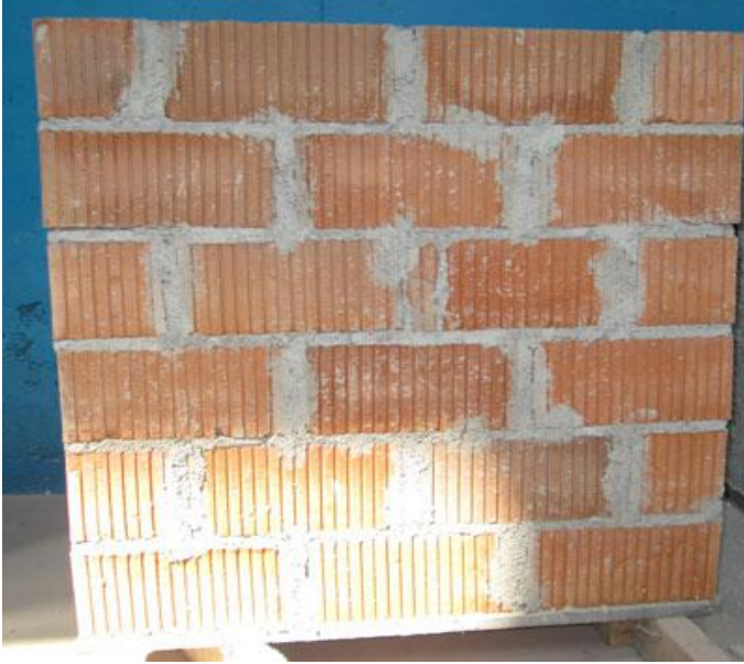
Yığma tuğla ile örölmüş duvar
