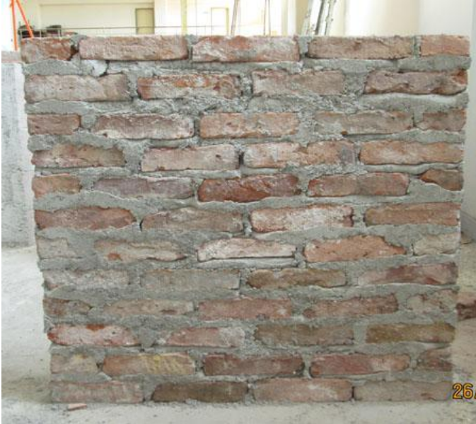
Harman tuğla ile örülmüş duvar
