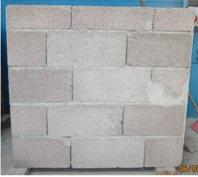
Bimsblok ile örölmüş duvar
