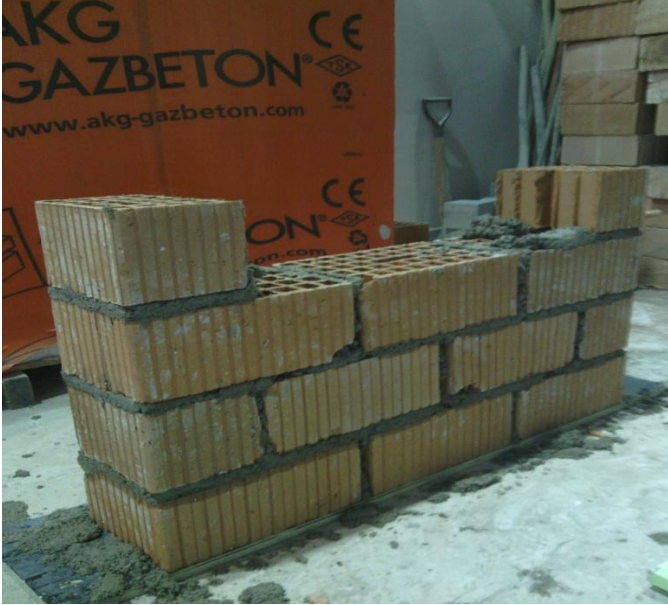
Yığma tuğla ile duvar örülmesi
