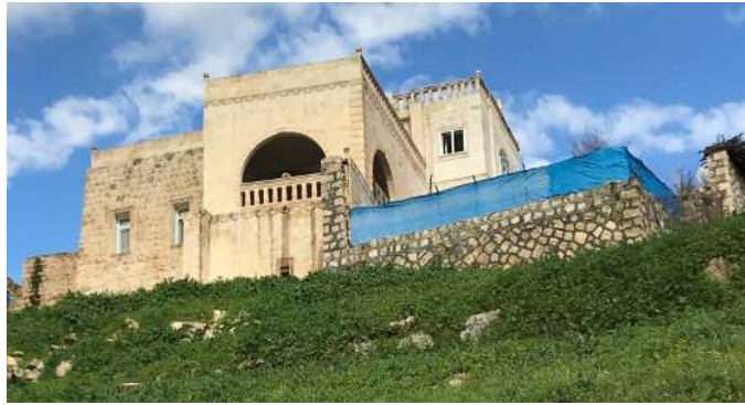
SAĞ YAN CEPHE
