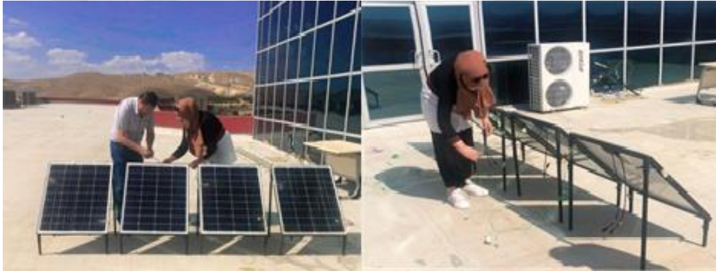
Şekil 3. 12. Güneş panellerinin kurulumu
