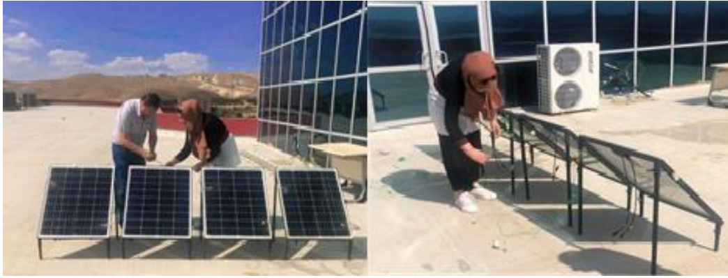
Şekil 3. 12. Güneş panellerinin kurulumu
