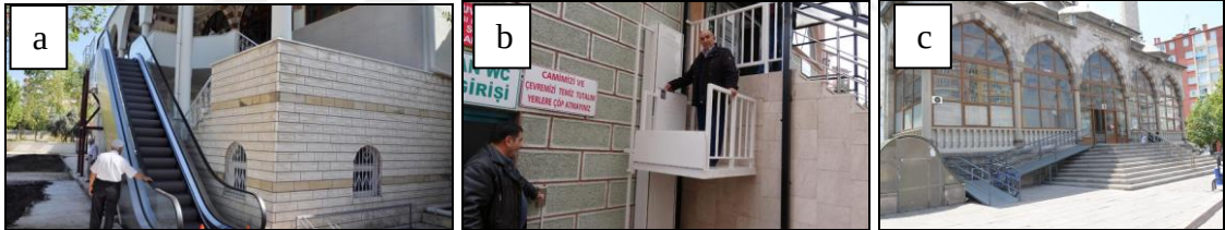
Şekil 4.2. a) Meltem Cami, yürüyen merdiven çözümü; b) Yeşil Cami, asansör çözümü; c) Melikgazi Cami, rampa çözümü
