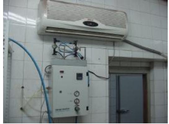
Şekil 3.7. Misel aşılınmış torbaların konulduğu büyütme odasındaki klima ve nem cihazı
