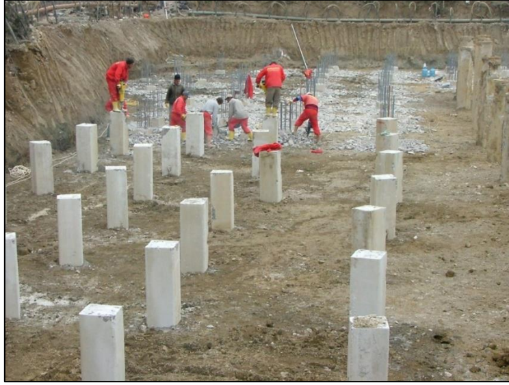
Resim 2.2 Betonarme çakma kazıkların imalatı (İnt.Kyn.2).
