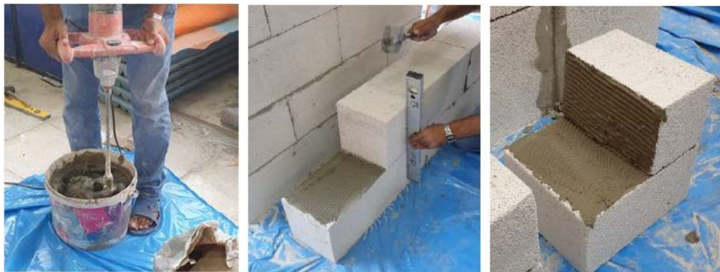
Şekil 4.1. Duvar numunelerinin imalat aşaması (Sabahoğlu 2022)
