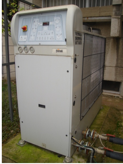
Şekil 3.3. Chiller soğutma grubu
