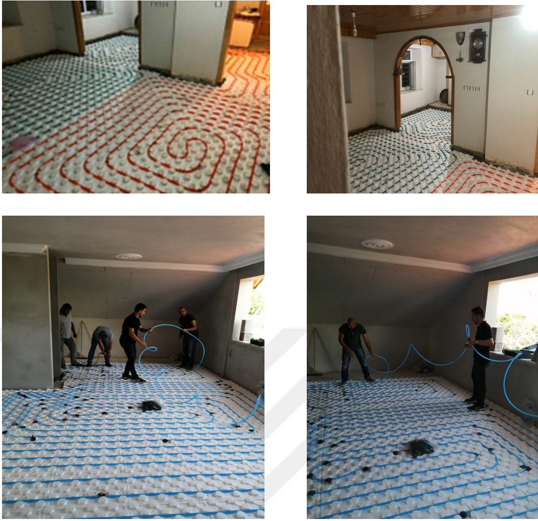
Şekil 4. Yerden ısıtma sistemi saha uygulamaları
