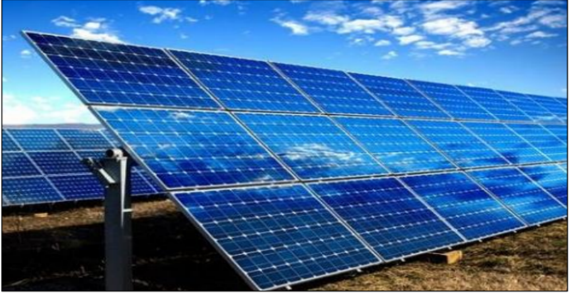
Şekil 12. Fotovoltaiik panel sistemi (Dal ve Yılmaz, 2020).
