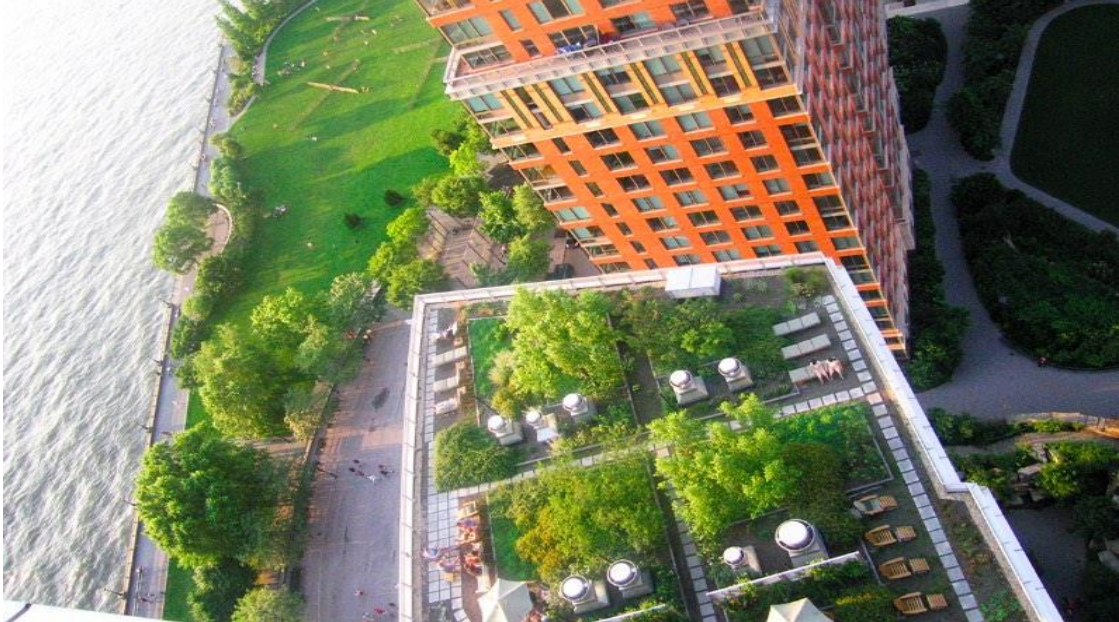
Şekil 6. Yoğun dokulu yeşil çatı (The Solaire, NYC, the first green residential building, ABD)
