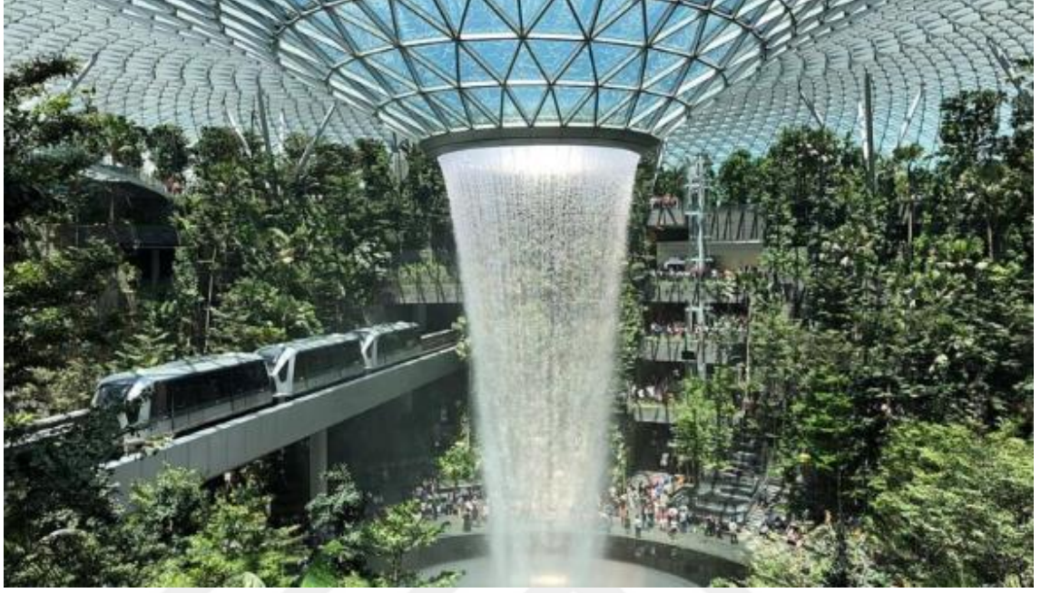
Şekil 3.1. Jewel Changi Havalimanı yağmur suyu bahçesi (Kara 2019).
