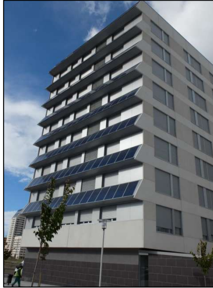
Şekil 4.19: Fotovoltik gölgelendirme elemanı kullanımı örneği.
