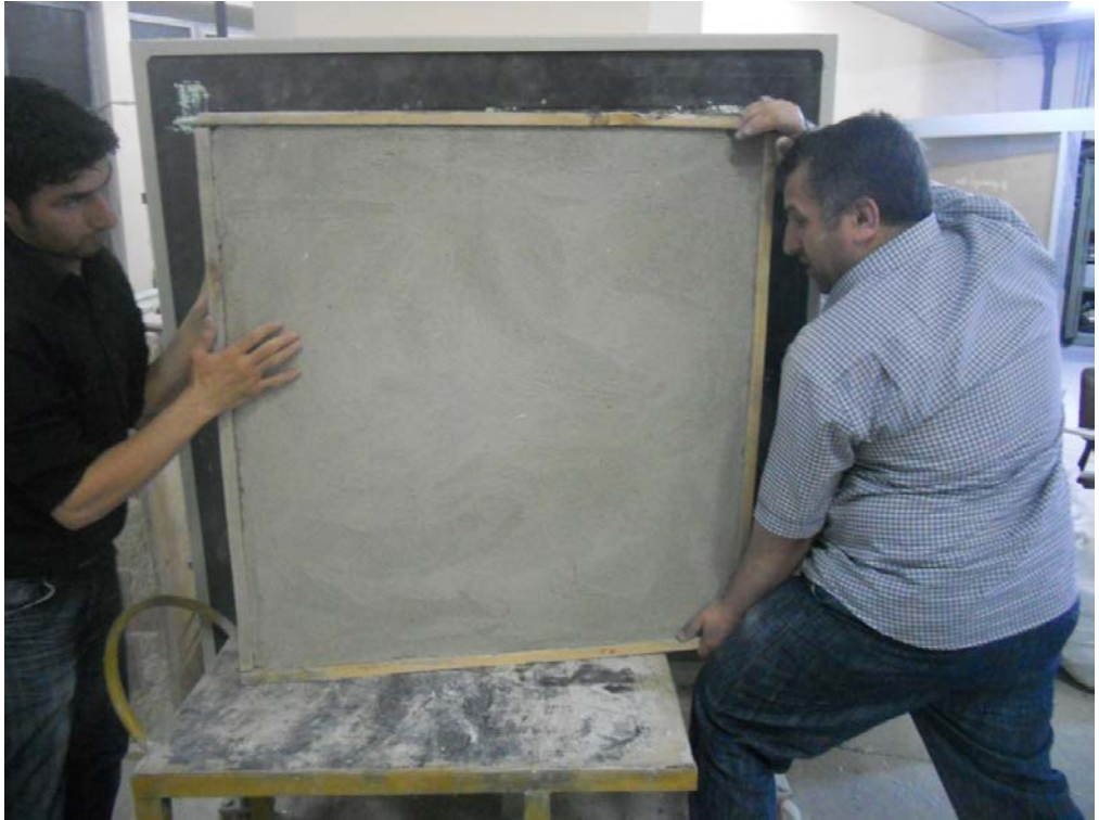
Şekil 3.8. Duvarın örnek bölmesine yerleştirilmesi
