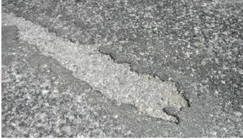
Şekil 2.4: Ayrışma bozulmasının tipik örneği
