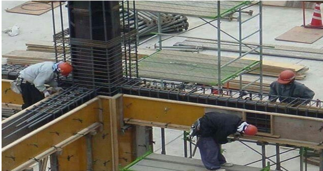
Şekil 2.9. Çelik gömme kompozit kolon-betonarme kiriş birleşimi (örnek)
