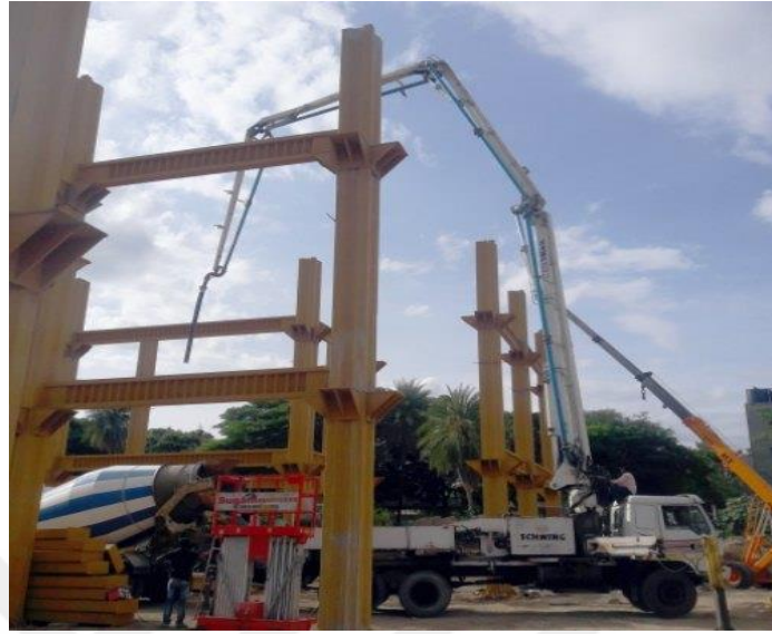
Şekil 2.10. Beton dolgulu kompozit kolon-çelik kiriş birleşimi (örnek 1)
