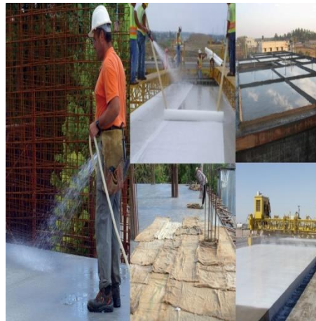
Şekil 2.9. Su püskürtmesi kürleme örneği [47]
