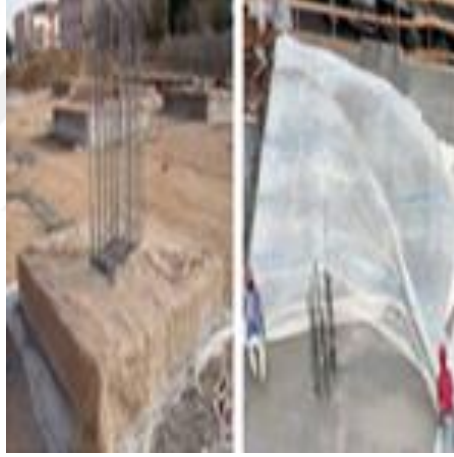
Şekil 2.10. Islak kaplama kür uygulamaları [47]
