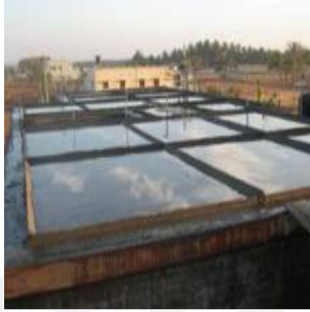
Şekil 2.8. Havuzlama kür yöntemi örneği [47]
