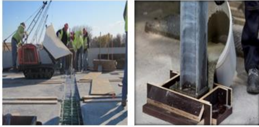
Şekil 2.2. Grout harçların yerleştirilmesi [15]
