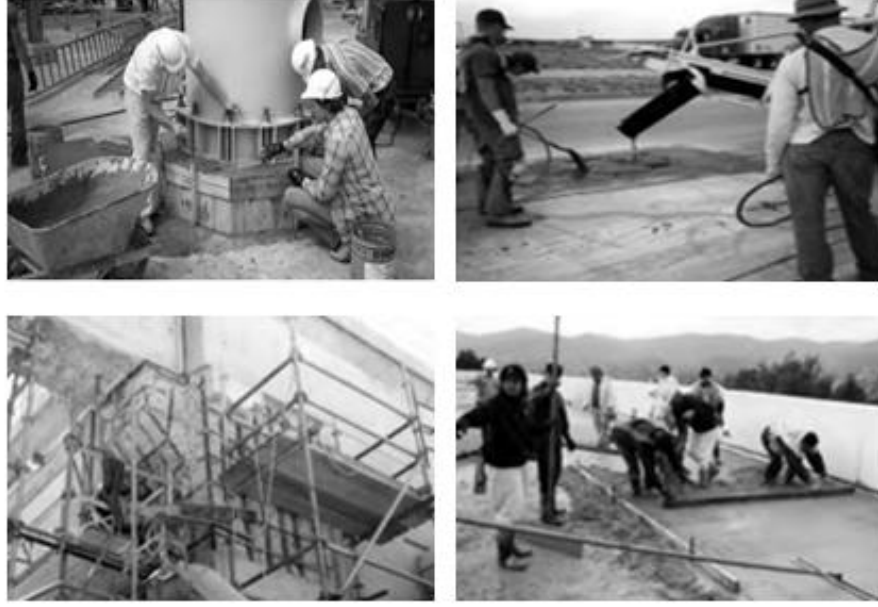
Şekil 2.6. Grout harç uygulamaları [33]
