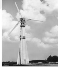
Resim 2.8 Smidth üç kanatlı rotorlu aeromotor [12] (rotor çapı 24 m, nominal güç yaklaşık 70 kW)
