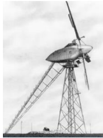
Resim 2.11 Rus rüzgâr türbini, Rüzgâr D-30 [12-13] (Rotor çapı 30 m, nominal güç 100 kW)
