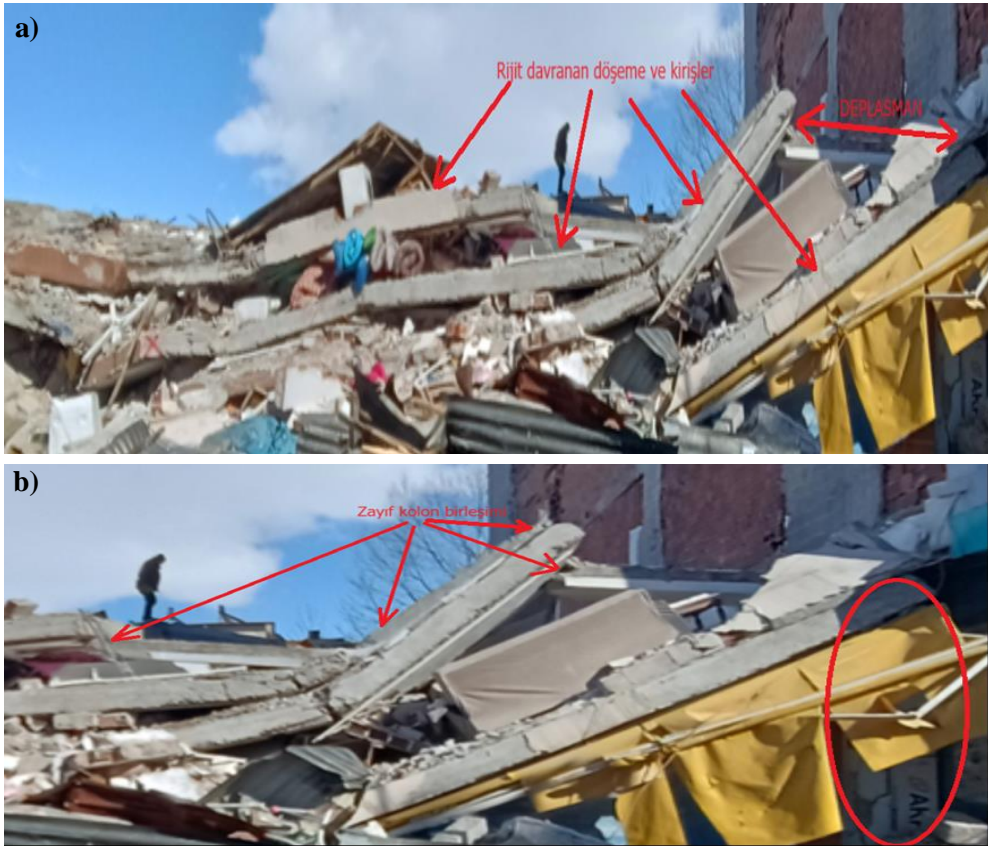
Şekil 2. 2023 Kahramanmaraş depremlerinde meydana gelen hasarlara örnekler: a) Rijit döşeme ve kiriş davranışı ve b) Zayıf kolon-güçlü kiriş birleşimi ve zayıf kat etkisi (Cakir vd., 2024).
