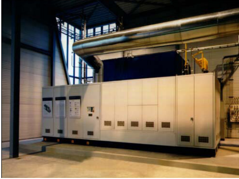
Resim 2.3. Siemens Westinghouse tarafından inşa edilmiş 5A boru şeklinde yakıt ünitesi elektrik santrali
