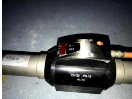
Şekil 3.7. Debimetre.
