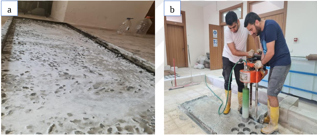
Şekil 3.19. YEK kaplamadan karot numunelerin alınması; a) YEK yüzeyi; b) Karot numunelerinin alınması
