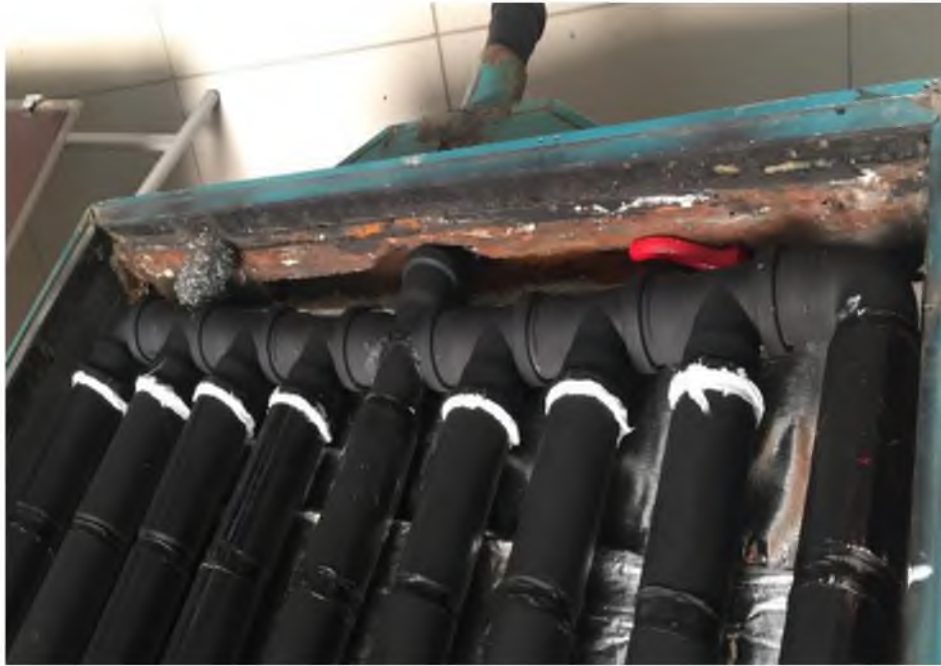
Şekil 5.5. Kola kutusu hatlarında sızdırmazlık sağlanırken
