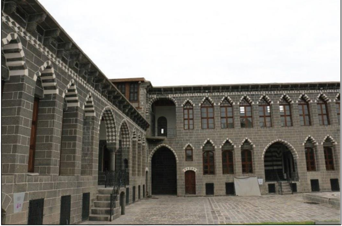
Şekil 1.2 Cemil Paşa Konağı, harem bölümü
