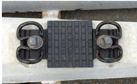
Görsel 2.4.4.1. Travers bağlantı elemanları. (TÜDEMSAŞ 2021)
