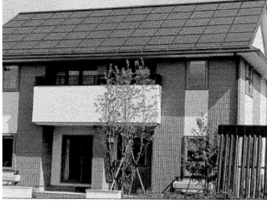
Şekil 2. 2. Çatısı güneş pili kaplı ev [7]
