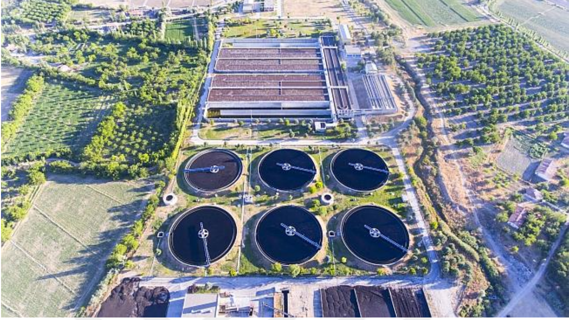
Resim 3.4. Malatya ileri biyolojik atıksu arıtma tesisi
