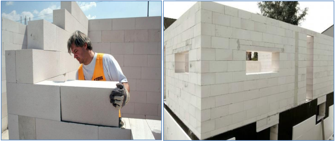
Şekil 2.11. Gazbeton ve duvar uygulaması (URL-8).
