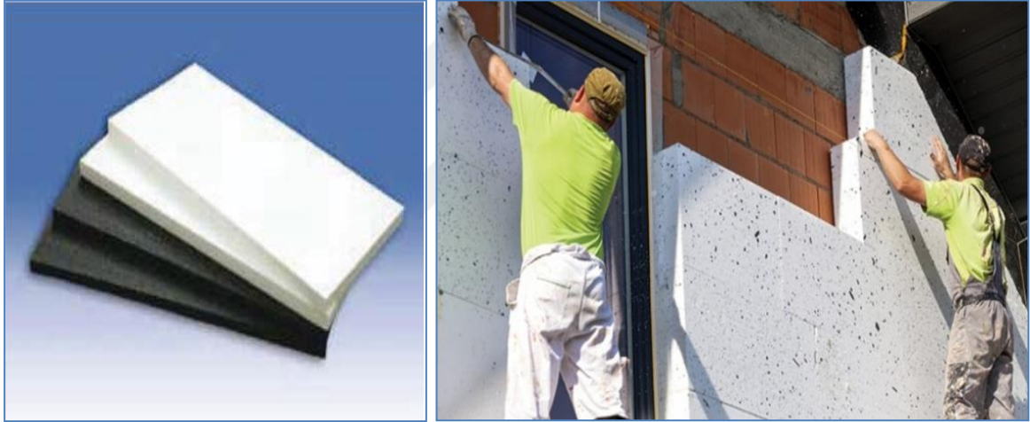
Şekil 2.7. Bina dış duvarıda eps uygulaması (URL-4).
