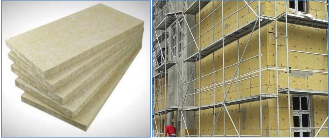
Şekil 2.6. Bina dış duvarı taşyünü uygulaması (URL-3).
