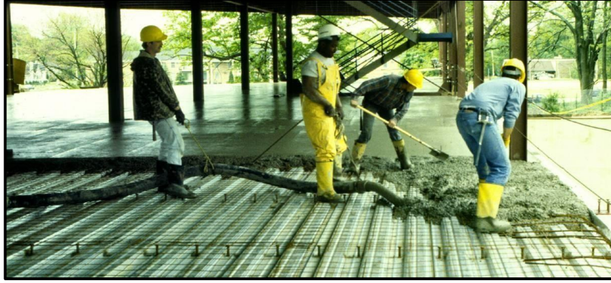
Şekil 4.7. Kompozit döşemede beton dökümü
