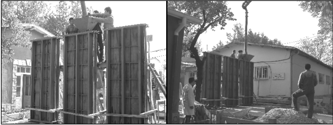
Resim 3.2. Beton döküm işlemleri
