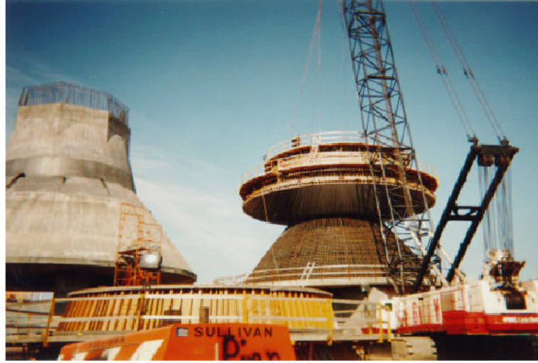
Resim 2.6. Konfederasyon köprüsü ayağının temeli üzerindeki tekstil atsarlı ahşap kalıp (140)
