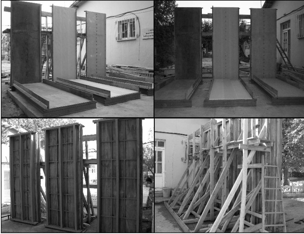
Resim 3.1. Kalıp örneklerinin yapım süreci ve tamamlanmış görüntüleri
