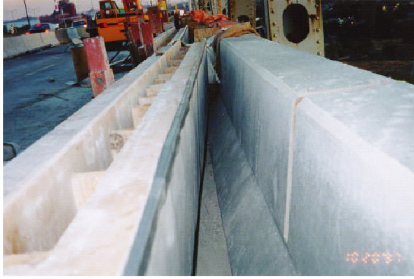
Resim 2.8. Trafik bariyerlerinin astarlı kalıplar kullanılarak dökülmesi
