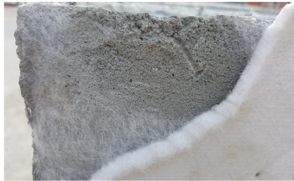
Şekil 5. 1. Geoplas astarla kaplanmış kalıptan çıkan beton
