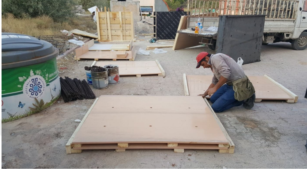
Şekil 3. 9. Kalıp kurulum işlemi
