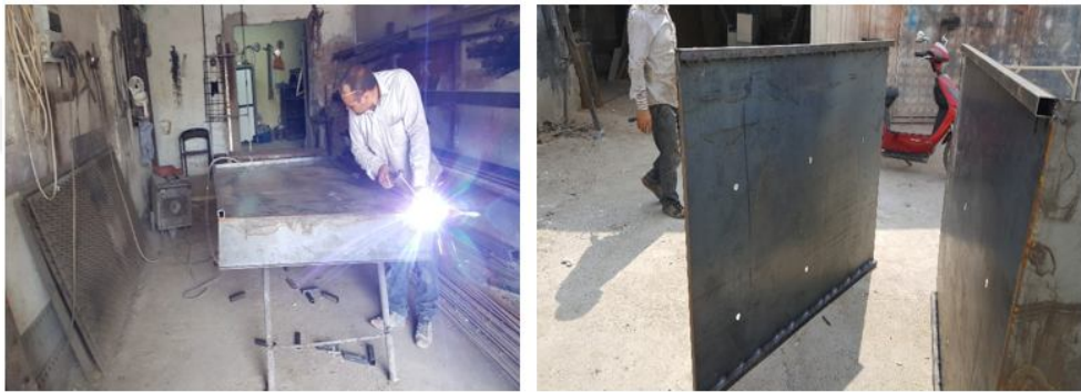
Şekil 3. 7. Sac kalıp güçlendirme işlemi
