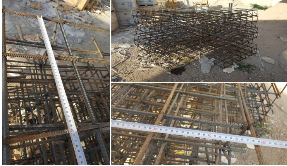
Şekil 3.13. Projeye göre hazırlanan donatılar
