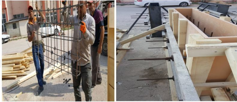
Şekil 3.14. Donatıların kalıp içine yerleştirilmesi
