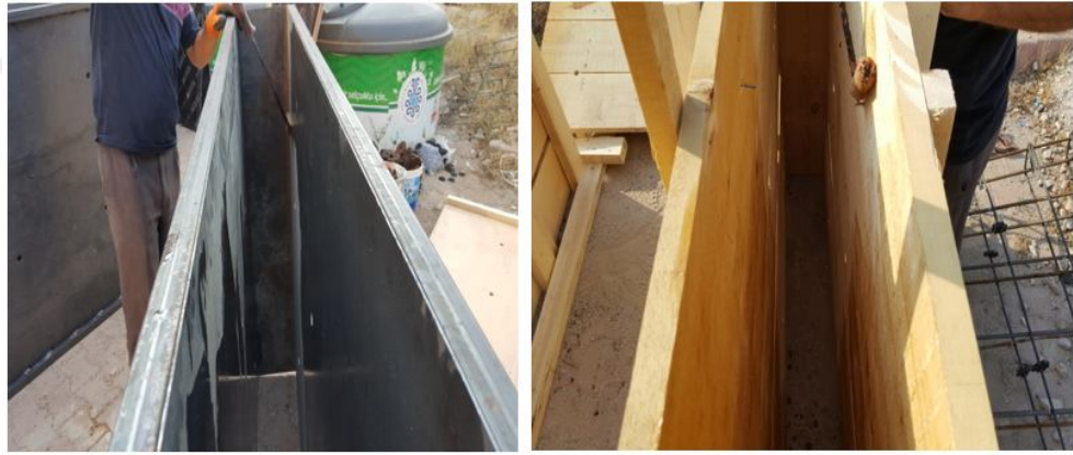
Şekil 3. 10. Kalıp iç yüzeylerinin kalıp yağı ile yağlanma işlemi
