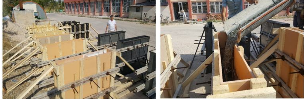
Şekil 3. 27. Kalıplara KYB beton dökme işlemi
