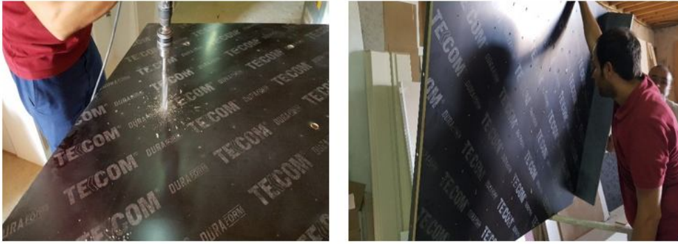
Şekil 3. 6. 24 mm tie-rod deliği açma işlemi
