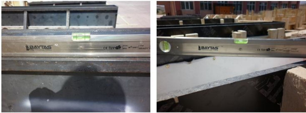
Şekil 3. 16. Kalıpların son kontrolleri
