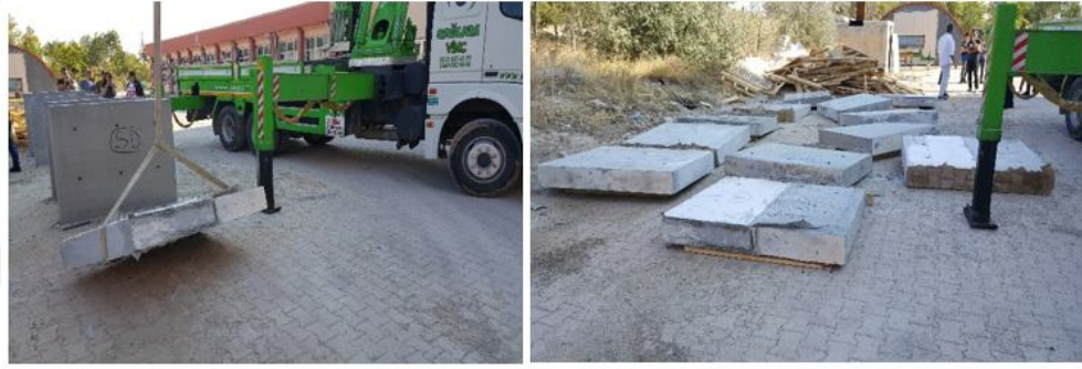
Şekil 3.31. Beton blokların yere yatırılma işlemi
