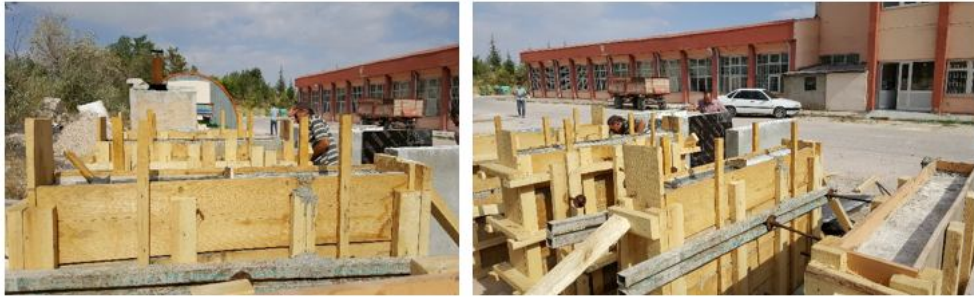
Şekil 3. 29. Kalıp söküm işlemi
