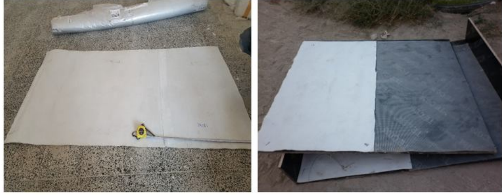
Şekil 3. 11. Geotekstil astarların kesim ve uygulaması
