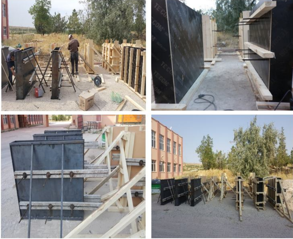
Şekil 3.15. Takviye ve tie-rod bağlantıları tamamlanmış kalıpların son hali
