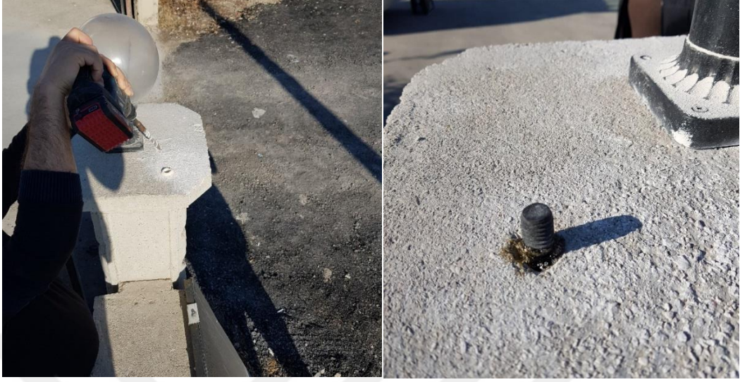
Şekil 3. 6: Total stationların yerleştirildiği vidalı platform
