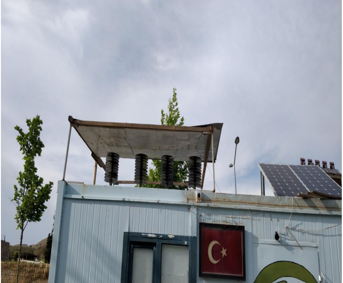
Şekil 2.27. Deney düzeneđindeki sistemlerin kurulumu tamamlanmış hali
