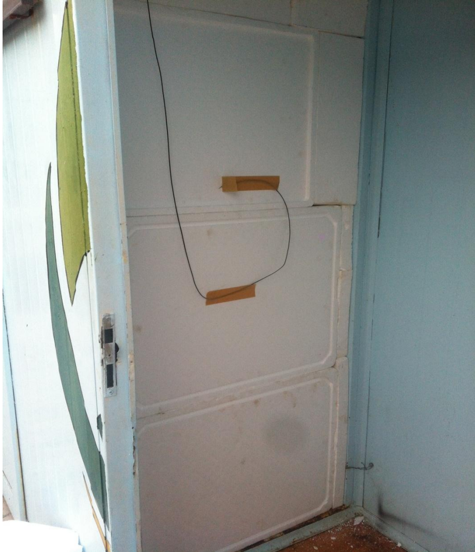
Şekil 2.3. Ölçüm odasının yalıtım malzemesiyle kapatılmış halinin görünümü
