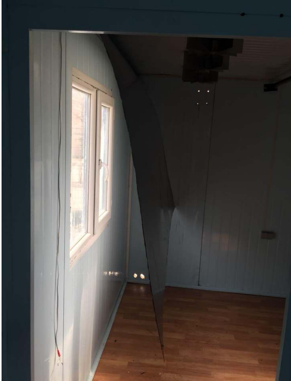
Şekil 2.11. Isıl enerji deposunun montajı öncesi çekilmiř fotoğrafı
