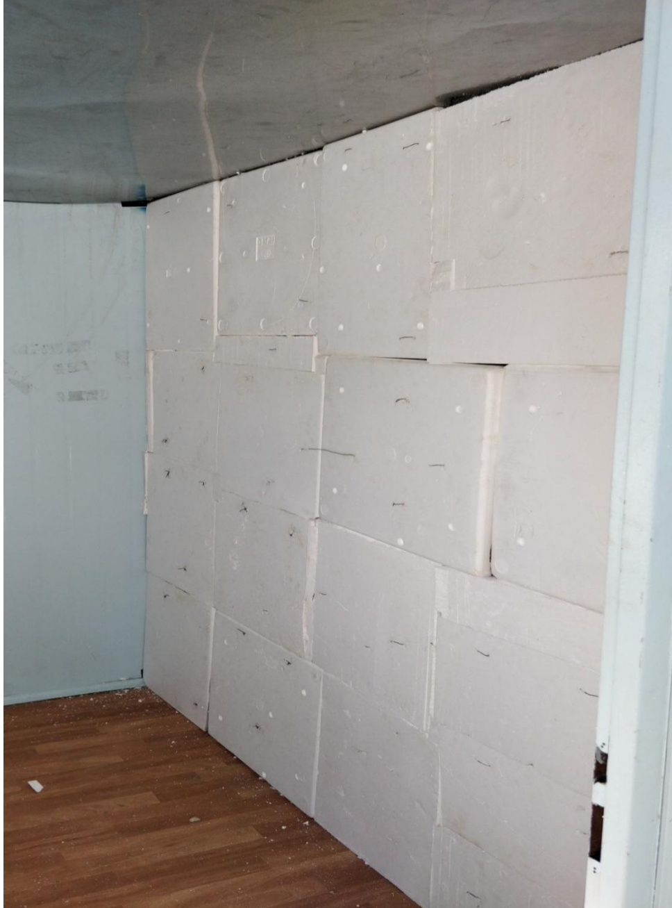
Şekil 2.5. Ölçüm odasının bölünmesinde kullanılan metal alaşımlı iskeletin üzerine yalıtım malzemesinin montajlanmış hali gösterilmiştir.
