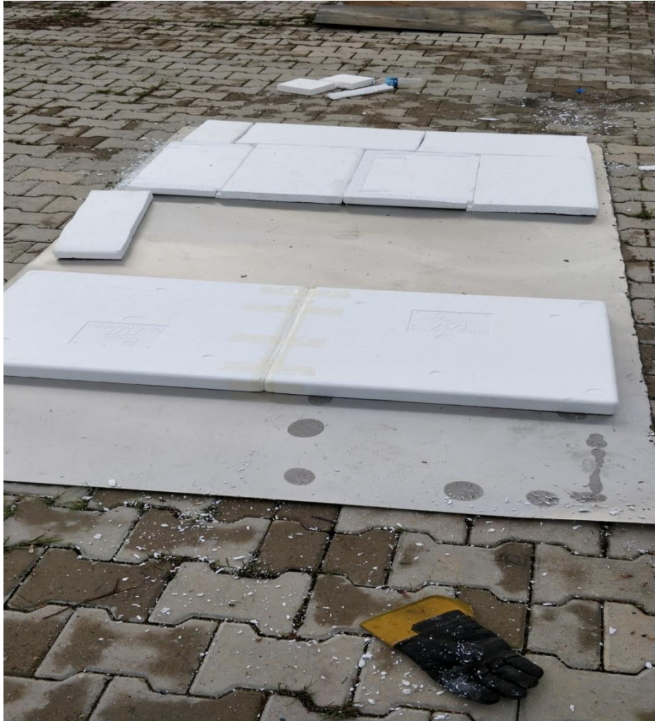
Şekil 2.26. Yalıtım için kullanılan metal levha ve yalıtım malzemesi
