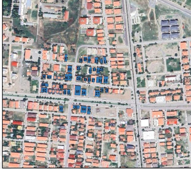
Şekil 5.2. Cumhuriyet mahallesinde değerlendirilen binalar
