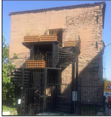
Şekil 3.10. Yığma sistem bina örneği
