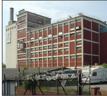
Şekil 3.8. Dolgu duvarlı betonarme çerçeve sistem bina örneği
