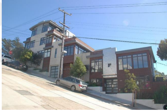
Şekil 3.17. Eğimli arazide bulunan bina (FEMA 154, 2015)
