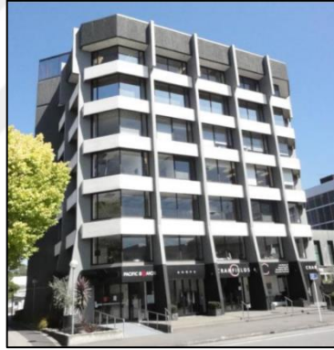
Şekil 3.6. Betonarme çerçeve sistem bina örneği.
