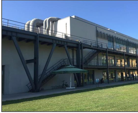
Şekil 3.3. Diyagonal çelik çerçeve sistem örneği (S2)
