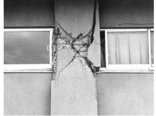
Şekil 3.14. Kısa kolon etkisi, bant penceresi tarafından oluşturulmuştur (Vahidi, 2009).
