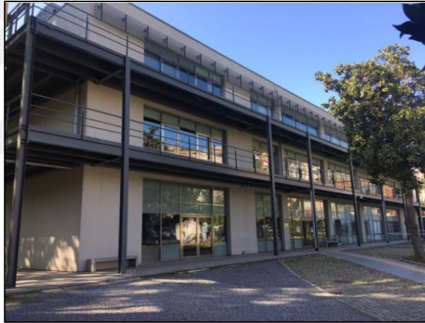
Şekil 3.2. Çelik çerçeve sistem (S1)
