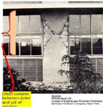
Şekil 3.14. Kısa kolon etkisi, bant penceresi tarafından oluşturulmuştur (Vahidi, 2009).
