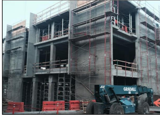
Şekil 3.7. Betonarme perde sistem bina örneği (C2)
