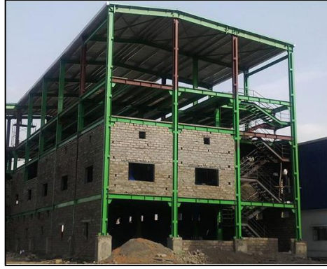
Şekil 3.5. Dolgu duvarlı çelik çerçeve sistem bina örneği
