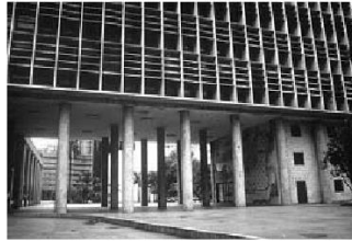
Şekil 3.12. a) İki Katlı yumuşak kat düzensizliği, Rio de Janeiro Milli Eğitim Bakanlığı’nın ana girişi (Fotoğraf: Jose Luis Colmenares) b) binanın farklı yükseklikteki kolonlarda kısmi yumuşak kat düzensizliği (Fotoğraf: Klaudia Laffaille)
