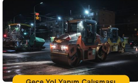
Gece Yol Yapım Çalışması
