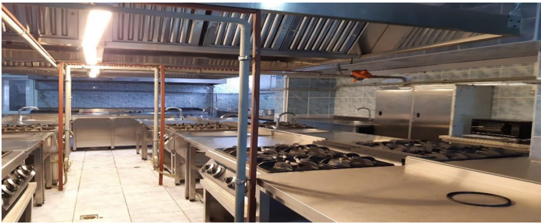
Resim 7.1.Davlumbazların otomatik söndürme sisteminin bulunmaması
