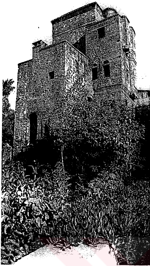
FIGURE.1.1. The Tower of the Cihanoğulları Mansion in Koçarlı
