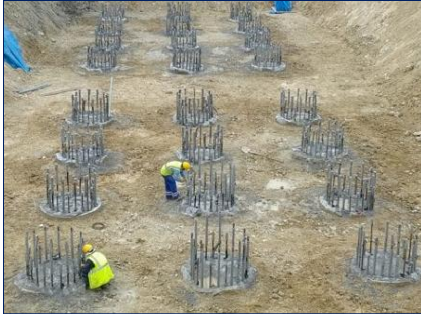
Şekil 3.6. Fore kazık uygulaması ( https://www.birimfiyatsec.com )
