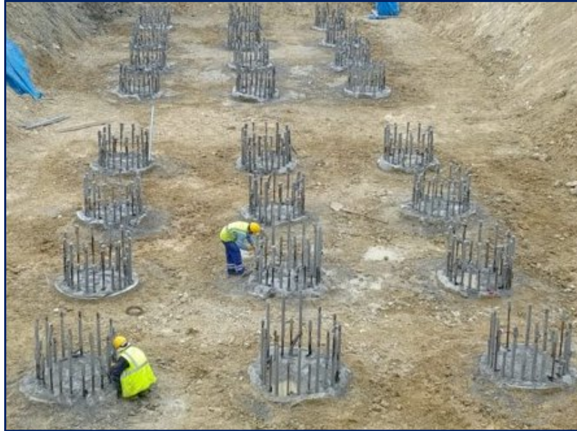
Şekil 3.6. Fore kazık uygulaması ( https://www.birimfiyatsec.com )
