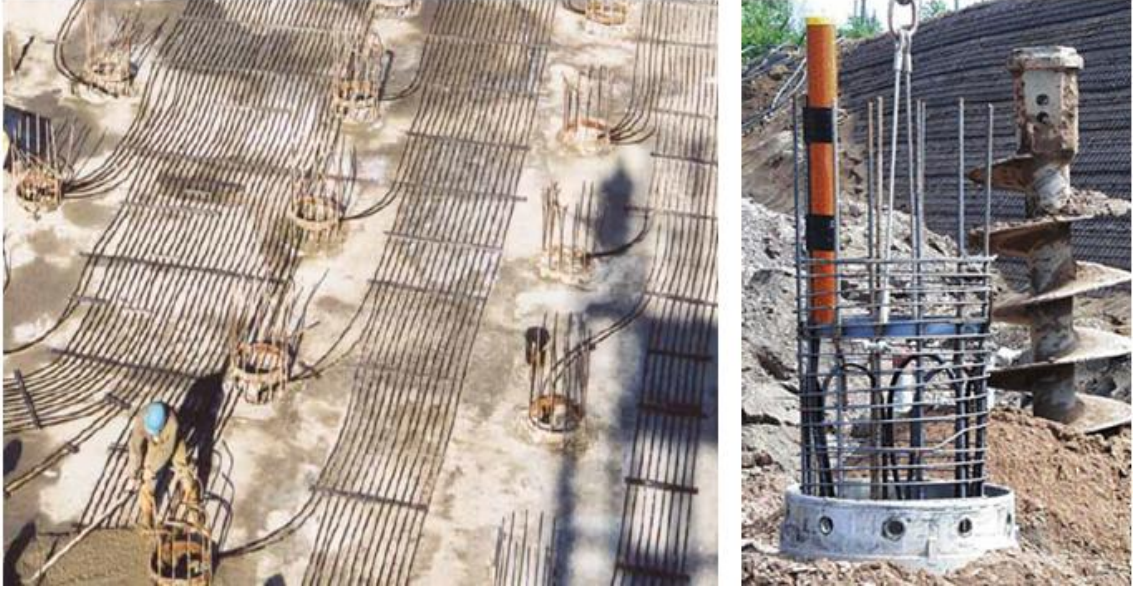
Şekil 4. 14 Zemine yerleştirilmiş enerji kazıkları
