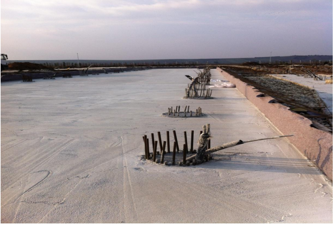
Şekil 6. 11 Enerji kazıklarının son hali
