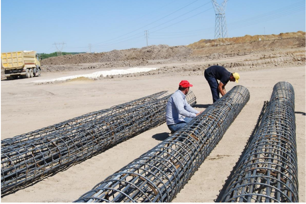
řekil 6. 5 Destek kafesinin hazırlanması
