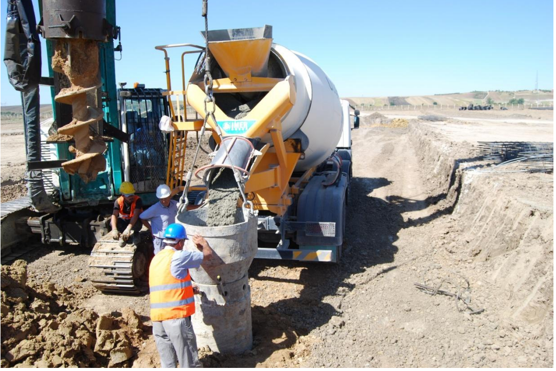
Şekil 6. 9 Huni yardımıyla harcın çukura dökülmesi
