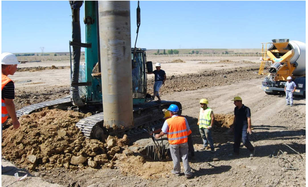
Şekil 6. 10 Muhafaza borusunun sondaj çukurundan çıkarılması
