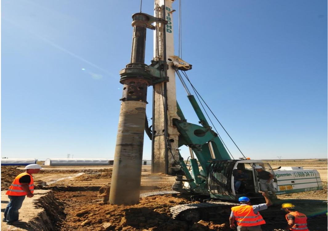
řekil 6. 6 Muhafaza borusunun yerleřmesi ve sondaj iřlemi
