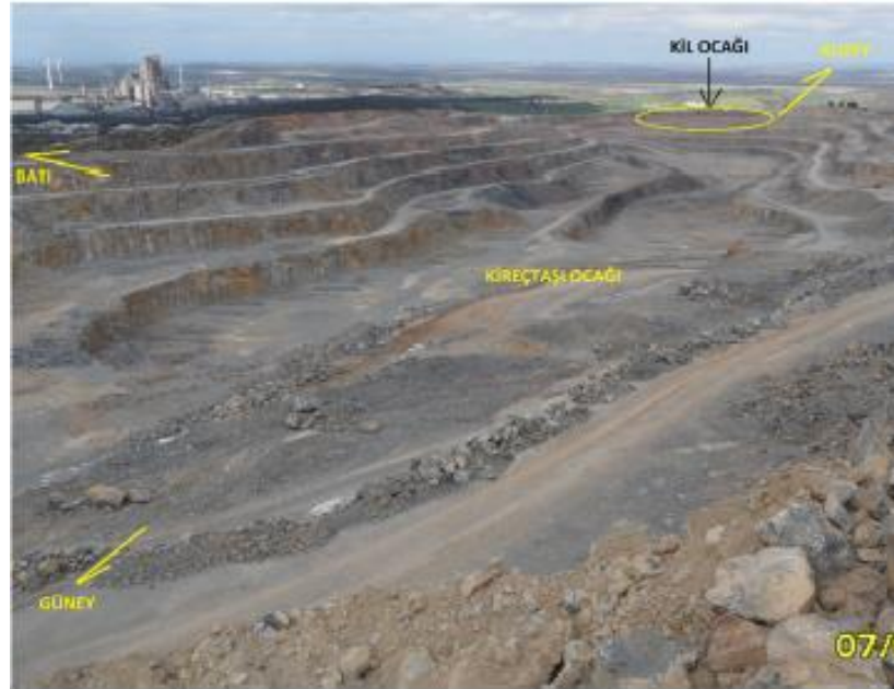
Şekil 3.2. Akçansa Çanakkale fabrikası kalker ocağı
