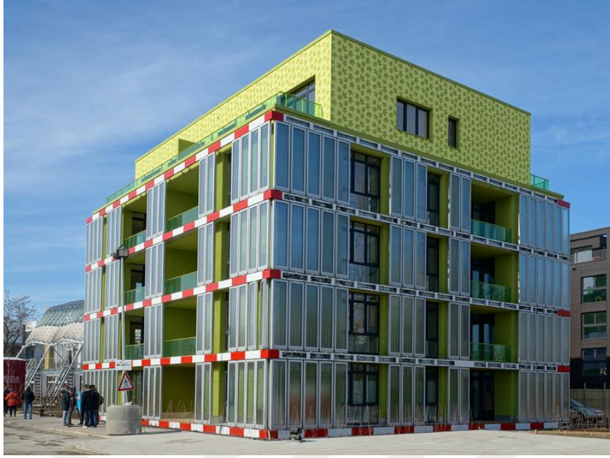
Şekil 2.8. Hamburg’da inşa edilen fotobiyoreaktör cepmeli bina (Anonim 4, 2013)
