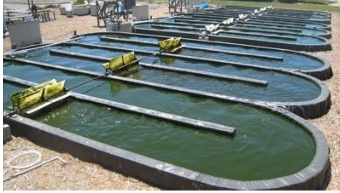
Şekil 11. Açık Sistem Alg Üretim Tesisi (Roshdy, 2019)
