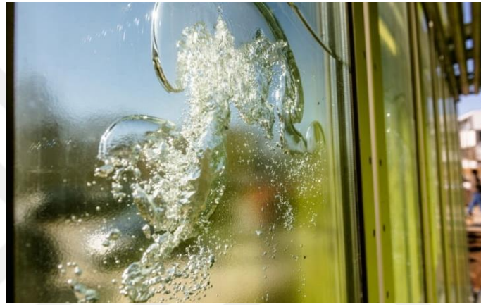
Şekil 43. BIQ Evi panelinde oluşan hava kabarcıkları (Nef, 2015)
