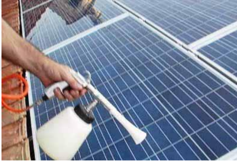
Şekil 5.3. Sprey tabanca ile fotokatalitik kaplama uygulaması
