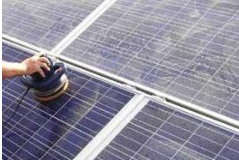
Şekil 5.2. Polisaj makinası ile nano teknolojik temizleme kimyasalı ile yüzeyin derinlemesine temizlenmesi
