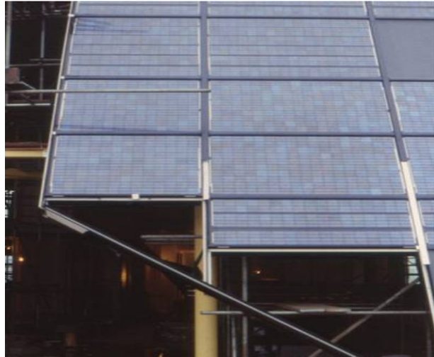
Şekil 3.21 PV kaplamalı binanın inşaat aşamasında çekilmiş resmi.
