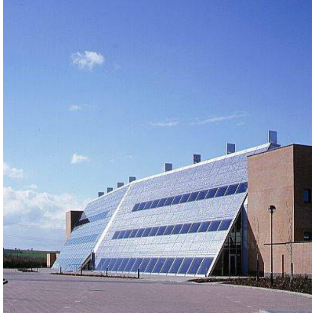
Şekil 3.20 PV kaplamalı binanın yandan görünümü.
