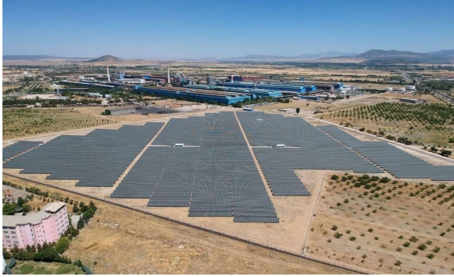
Şekil 2.2. Arazi güneş enerji santrali uygulaması
