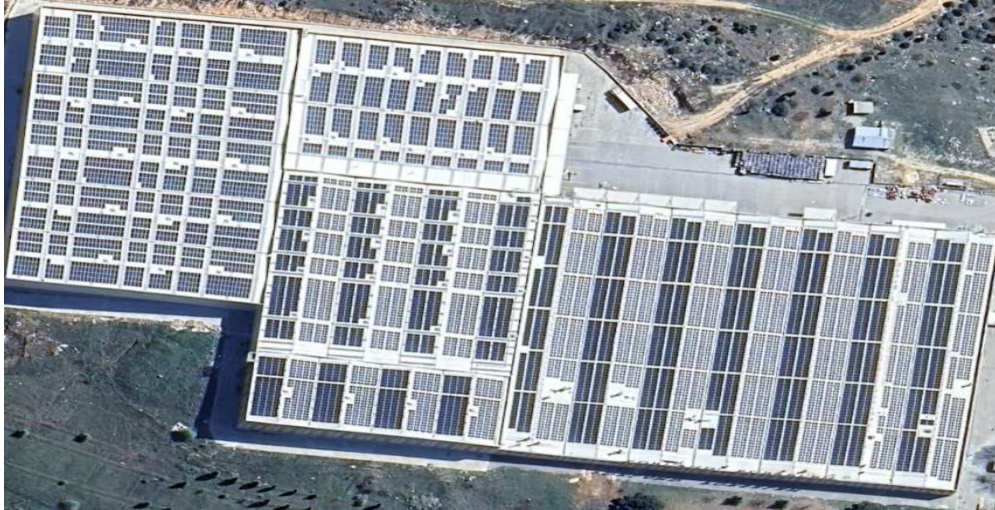
Şekil 2.1. Çatı üstü güneş enerji santrali uygulaması
