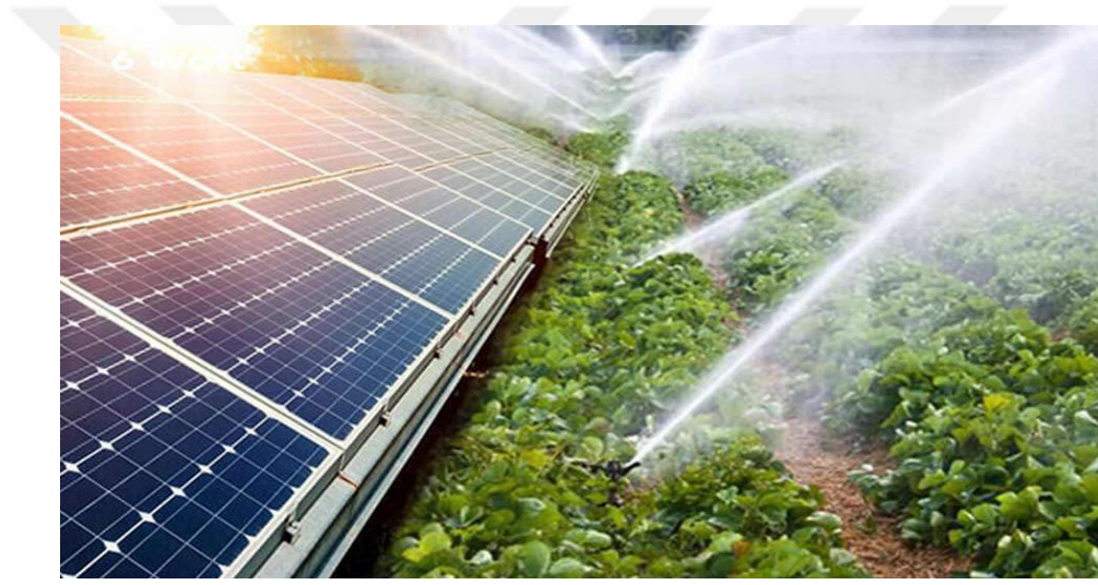
Şekil 2.4. Tarımsal sulama güneş enerji santrali uygulaması
